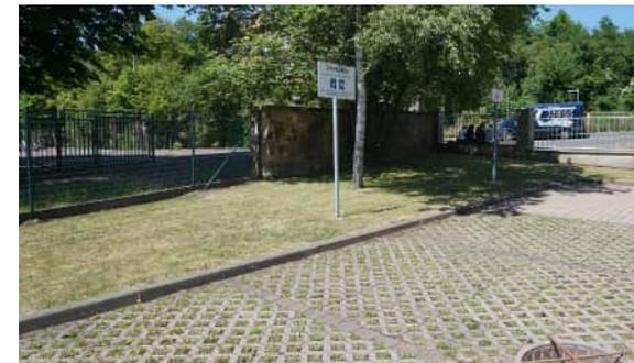
Abbildung 223: Teile des Parkplatzes sind bereits teilsiegt
