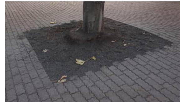
Abbildung 83: Zu sanierende Baumscheibe
