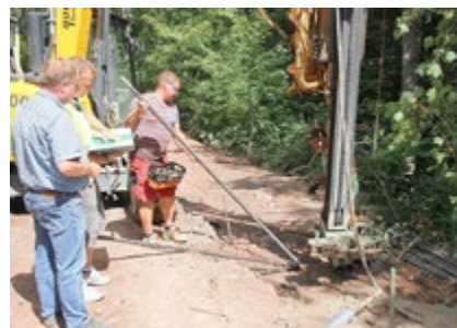
| Sascha Cramer von der Krausser Ingenieure GmbH und der Bauleiter aus dem Landratsamt, Thomas Gruhl, überprüfen den Baufortschritt, während Christoph Abraham und Hartmut Franz (v.l.) den nächsten Mikropfahl einsetzen.
