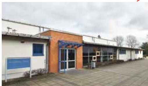
Körnerhalle am Perthes-Gymnasium Friedrichroda
