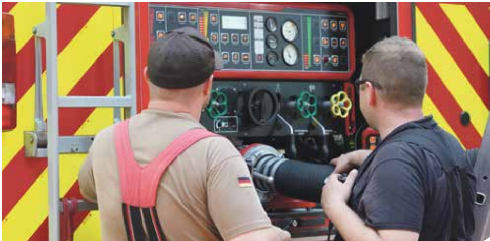
► Hier sitzt jeder Handgriff: Einsatzkräfte überprüfen die ordnungsgemäße Funktion der Pumpe.
