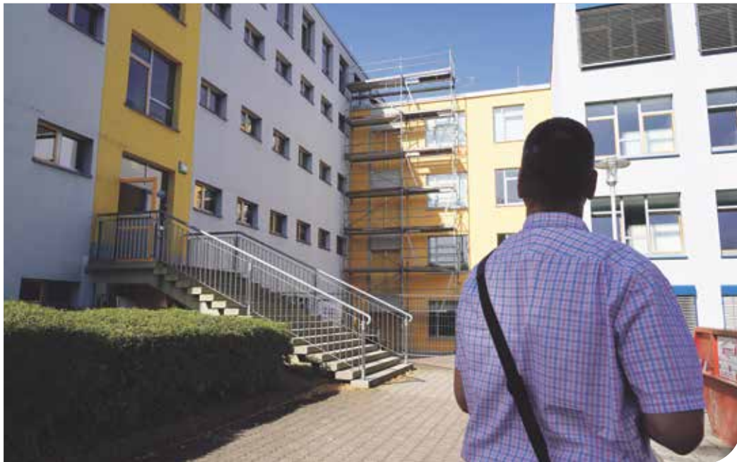
➤ Das Perthes-Gymnasium wird barrierefrei: Für den neuen Aufzug wurden Wände verschoben und Durchbrüche in der Außenwand gemacht.
