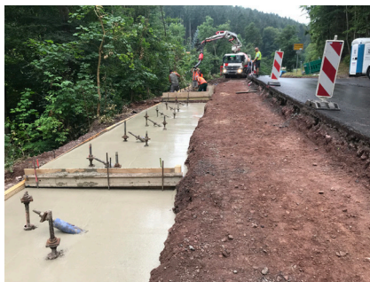
Hier erfolgt der Einbau einer Sauberkeitsschicht um die Mikrobohrpfähle.
