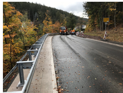
Abschließend wurden die Leitblanken montiert.
