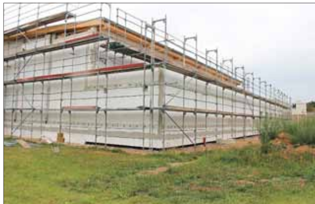
An der Grundschule Friemar entsteht neben einer neuen Turnhalle auch eine Freisportanlage.
