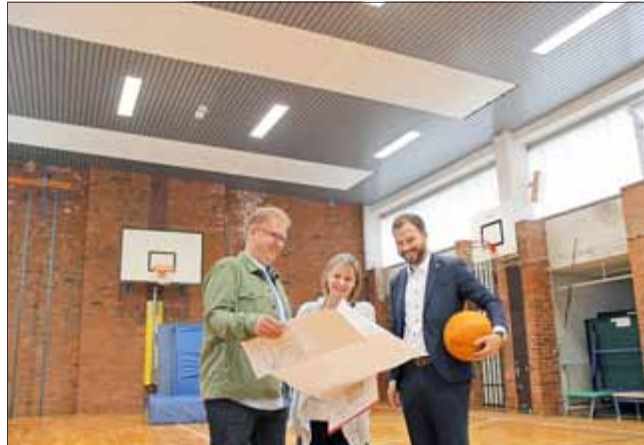
Bauleiter Frank Riede (l.) und die kommissarische Amtsleiterin für Gebäudemangement, Anika Kühn, besichtigten gemeinsam mit Landrat Onno Eckert die sanierte Decke der Turnhalle in Molschleben.
