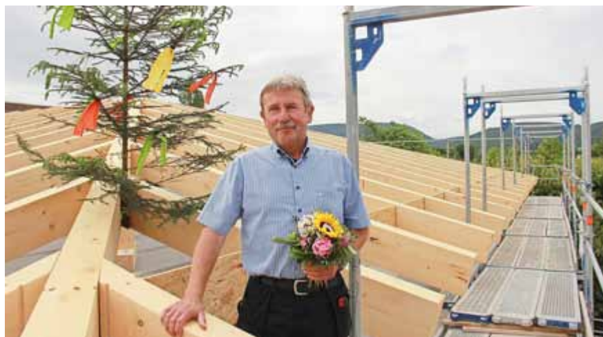
Bauingenieur Reiner Kunze brachte den feierlichen Richtspruch am Rohbau des Erweiterungsneubaus aus.
