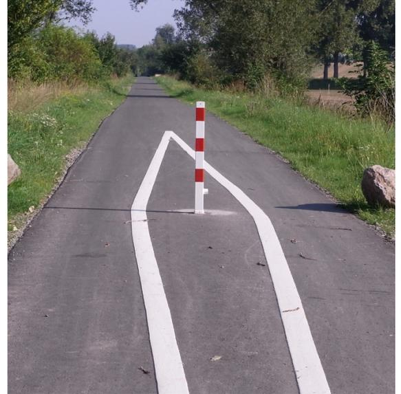
Warnmarkierung eines Sperrpfostens
